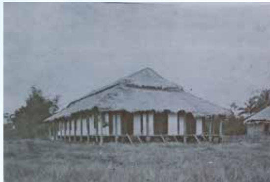
Nhà nguyện Kon Hring 1891. Ảnh: MEP
