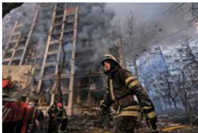
Cơ sở hạ tầng chịu thiệt hại nặng nề nhất. Ảnh NBCnews
